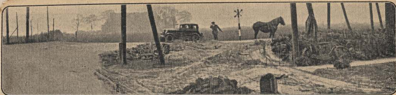
IN DEN WEG UITHUIZERMEEDEN—OOSTERNIELAND wordt een scherpe bocht belangrijk afgesneden en flauwer gemaakt, hetgeen een groote verkeersverbetering en een kans op minder ongelukken beteekent.
